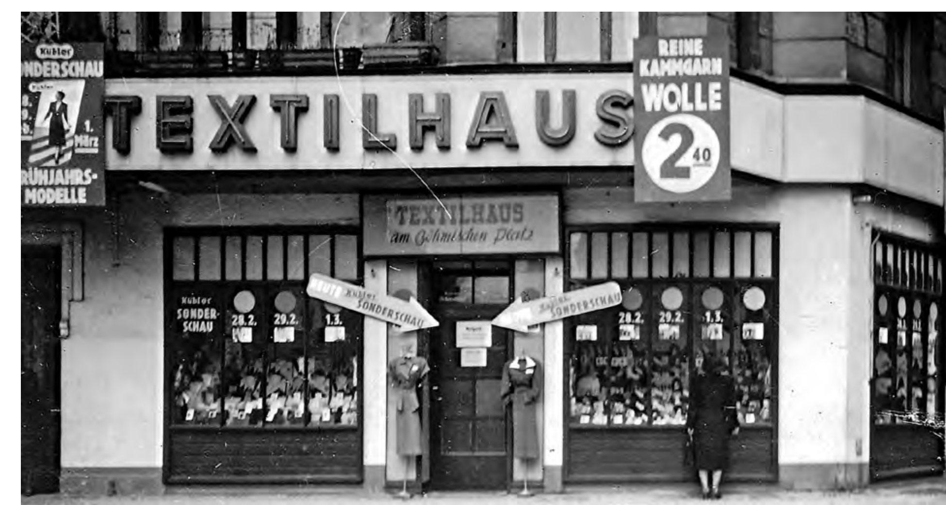
▲ Schaufensterauslagen des Textilhauses am Böhmischen Platz, genannt Klein Hertie, 1952 (© Gudrun Radev, Layoutmanufaktur)
