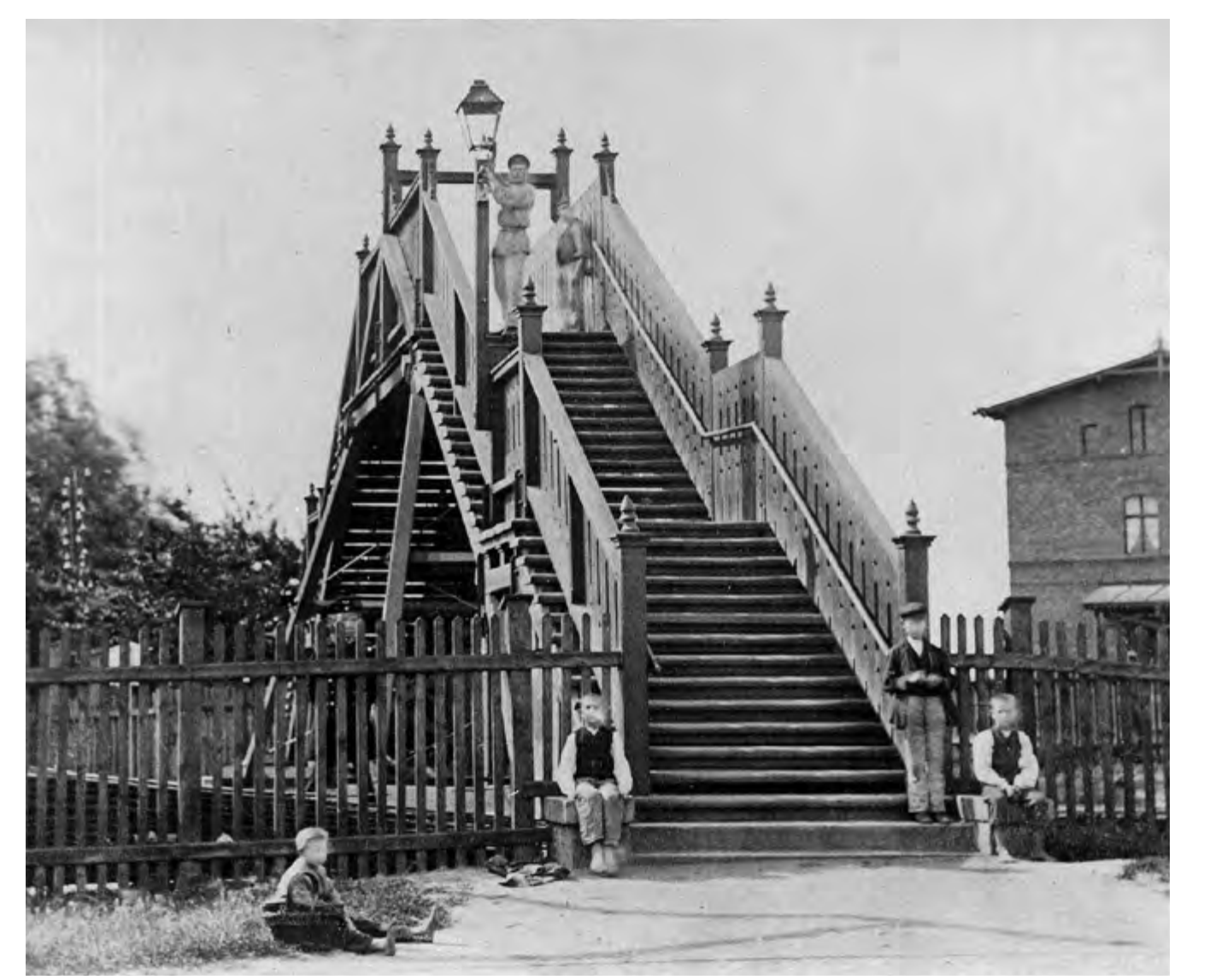
▲ Fußgängerbrücke (»Rixdorfer Galgen«) über die Bahnanlagen am Bahnhof Rixdorf, 1895 (©Landesarchiv Berlin; F. Rep. 290 (02) Nr. 253230)
